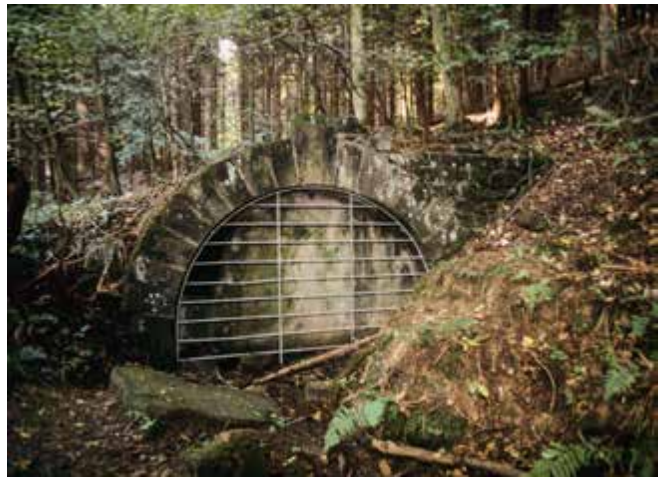
4 Stollenmundloch eines aufgelassenen Bergwerks im Mausbachtal bei Stift Neuburg. Hier wurde im 19. Jh. in einem 460 m langen Stollen ein etwa 1 m mächtiges Lager von Manganmulm aus der Zechsteinzeit abgebaut.
