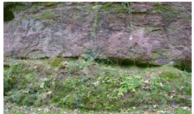
3 Aufschluss im Schlossgraben zwischen Brückenhaus und Unterem Fürstenbrunnen. Er zeigt den Kontakt zwischen Heidelberger Granit und den auflagernden grobklastischen Sedimenten des höheren Permokarbons. Die flach nach Südwesten einfallende Hohlkehle kennzeichnet die ehemalige Landoberfläche.
